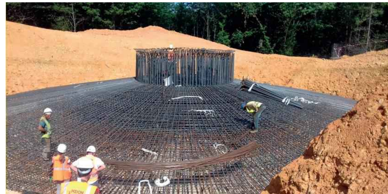
Photographie 4 Ferrailage d'une fondation Source : Engie Green
