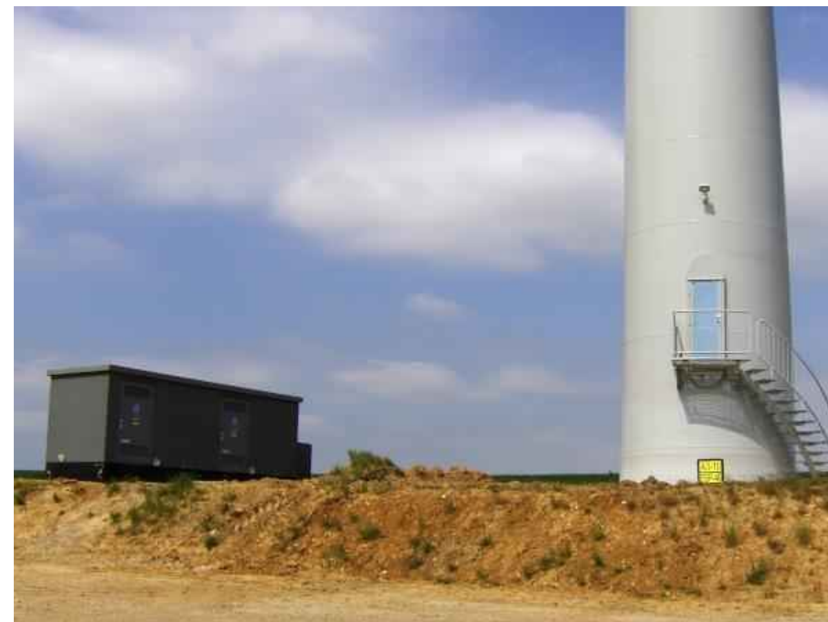
Photographie 6 Poste de livraison
