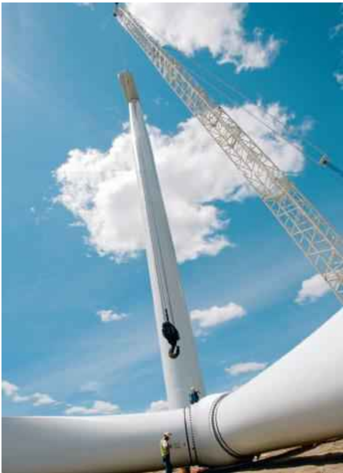
Photographie 1 Assemblage d'une pale Source : energie verte online
