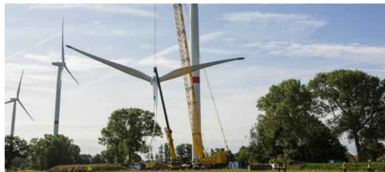
Photographie 8 Levage d'un rotor
