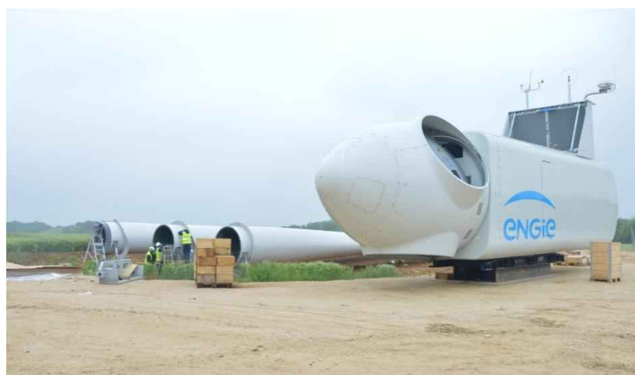
Photographie 7 Aire de montage
