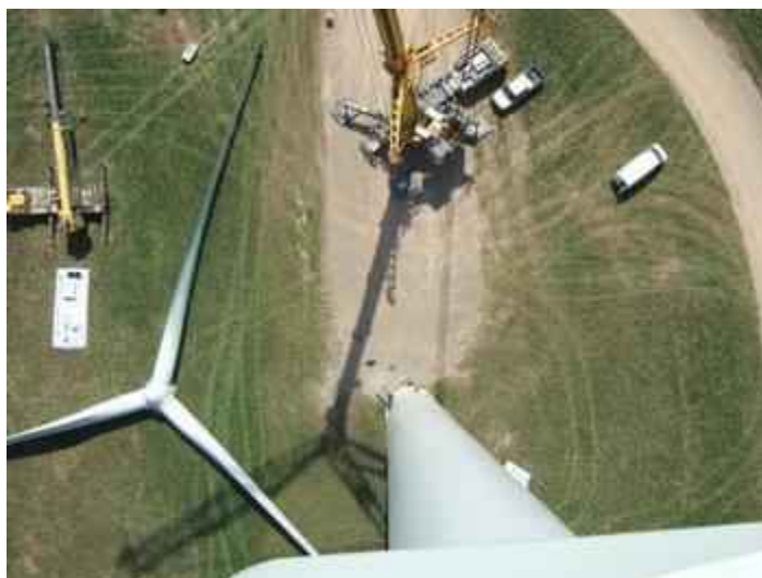
Photographie 5 Aire de grutage
